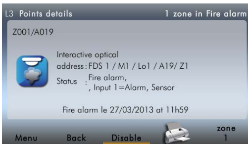
Dettaglio di un punto
